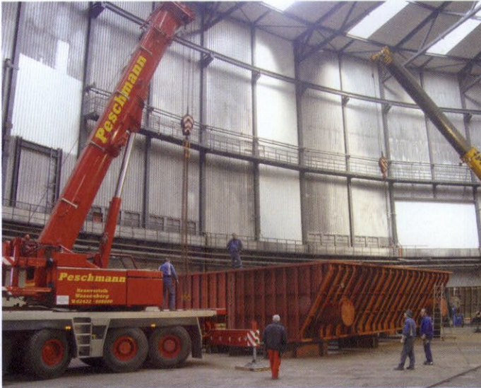
Die zwei Hauben eines Wärmetauschers wurden per Kran aus der Produktionshalle gebracht.
