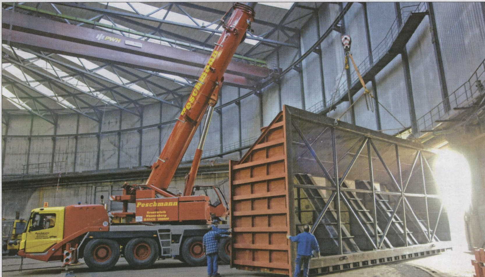
Eine schwierige Aufgabe müssen die Kranführer und die Küppers-Crew bei der Verladung der Wärmetauscher-Hauben lösen. Die 72 Tonnen schweren Teile passen nur knapp durch das Eingangstor der ehemaligen Kohlenwäsche von Sophia-Jacoba.
