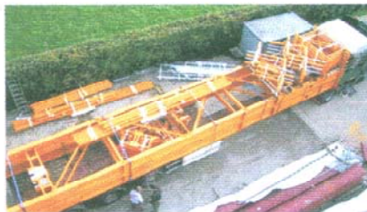
Beim Bau der Kranbrücken wurde mit einer Genauigkeit von +/- 1 Millimeter gearbeitet – Lasertechnik macht's möglich. | Foto: Küppers
